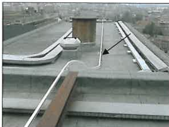
Toiture / accès antenne gsm
