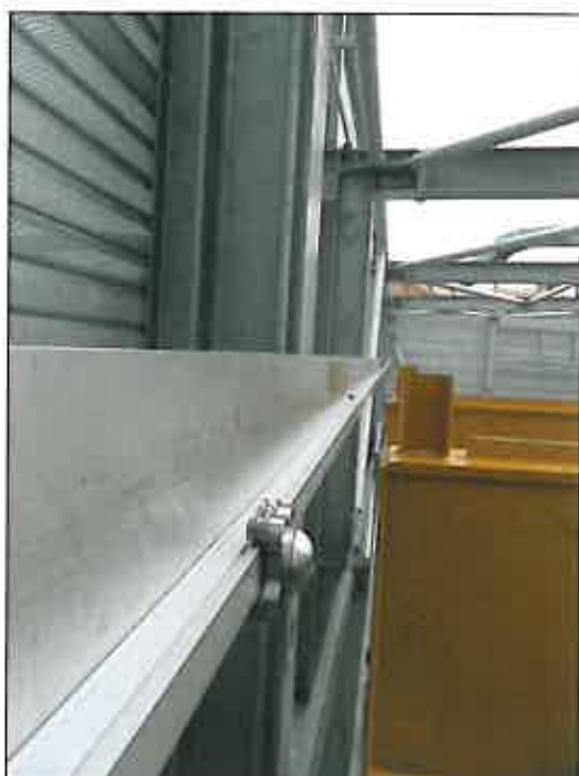
Chemin accès pont roulant / travée 7 mètres. Rail fixé sur tube renfort alu. 150x50x4mm
