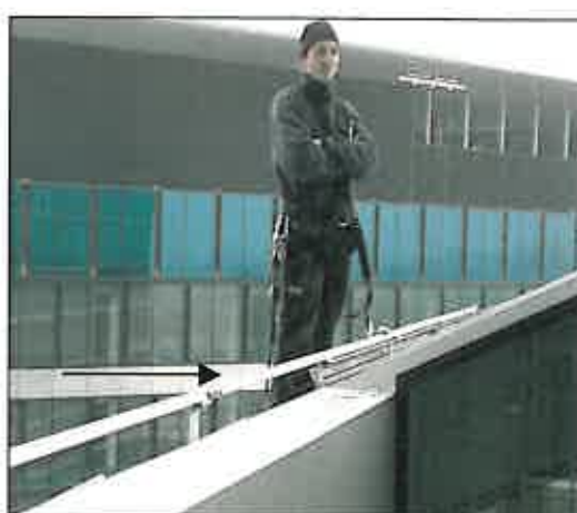
Toiture verrière - entretien
