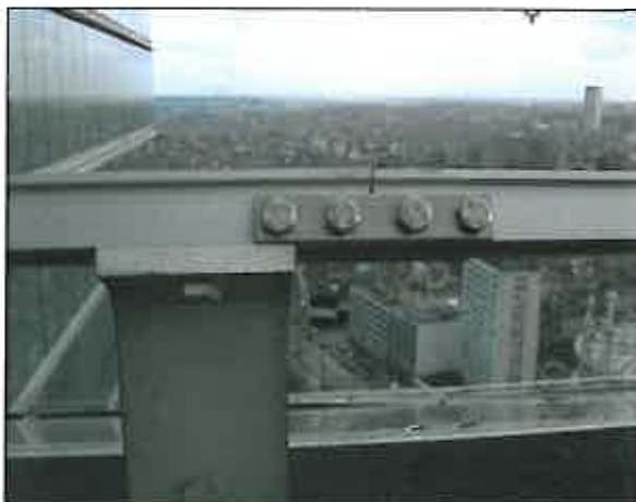
Toiture verrière - entretien
