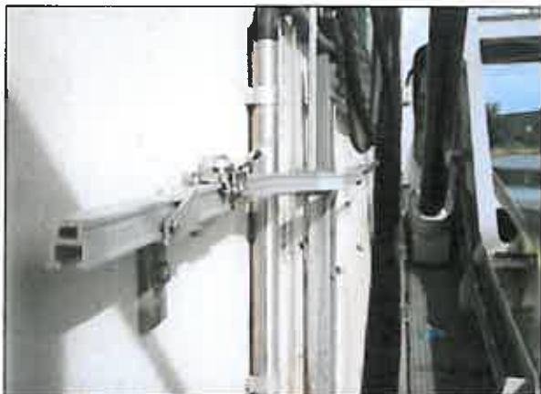
Barrage / accès machine
