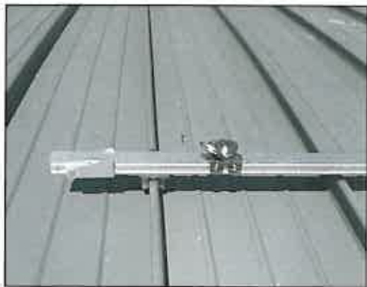
Accès toiture Kalzip
