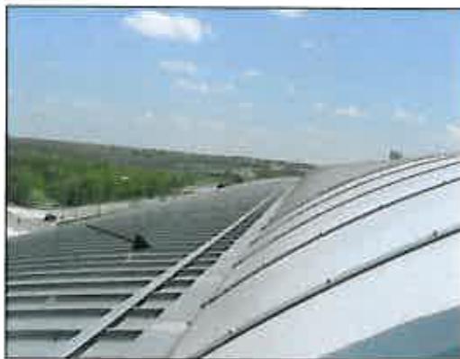
Accès toiture Kalzip
