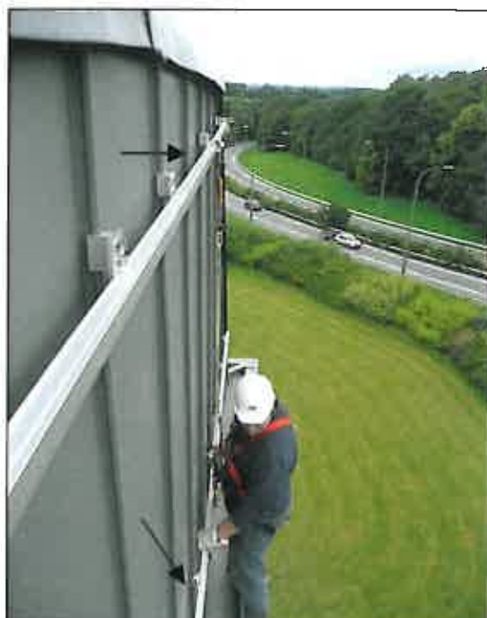
Accès toiture zinc - entretien
