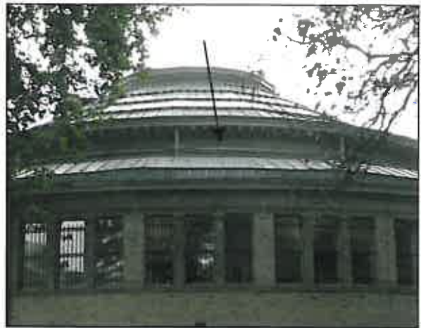
Descente toiture - entretien
